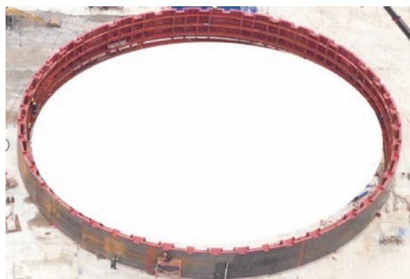
图2 现场钢模板试拼装
