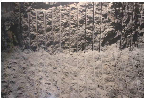
图 6 岩锚梁开挖效果图
