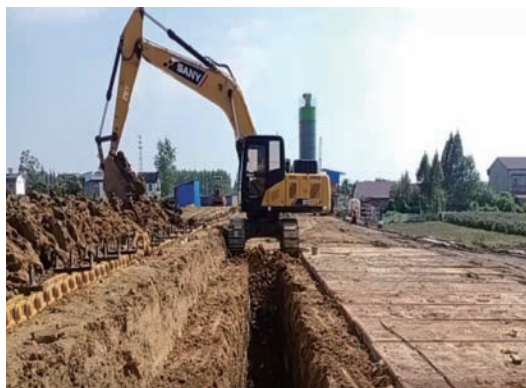
图 2 开挖沟槽
