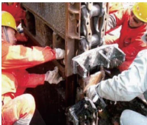
图 5 连接切割箱与主机
