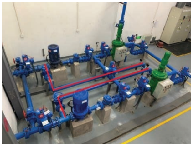
图2 改造后技术供水取水线路
