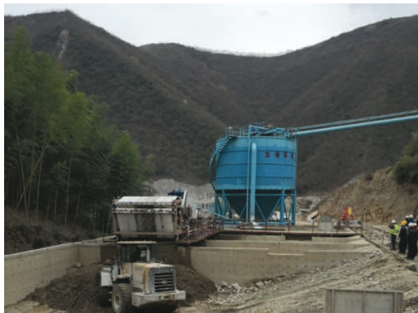
图 4 黄金峡砂石加工系统高效废水处理设备现场
