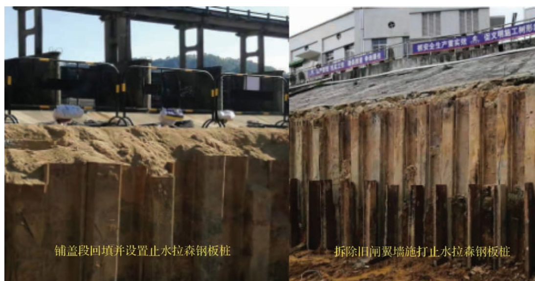
图 10 铺盖前、翼墙边施打止水拉森钢板桩
