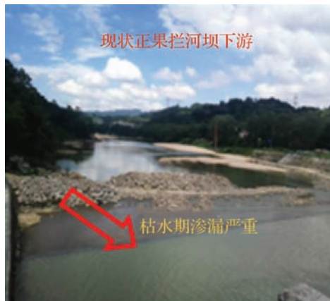
图 3 枯水期闸室底板渗漏明显
