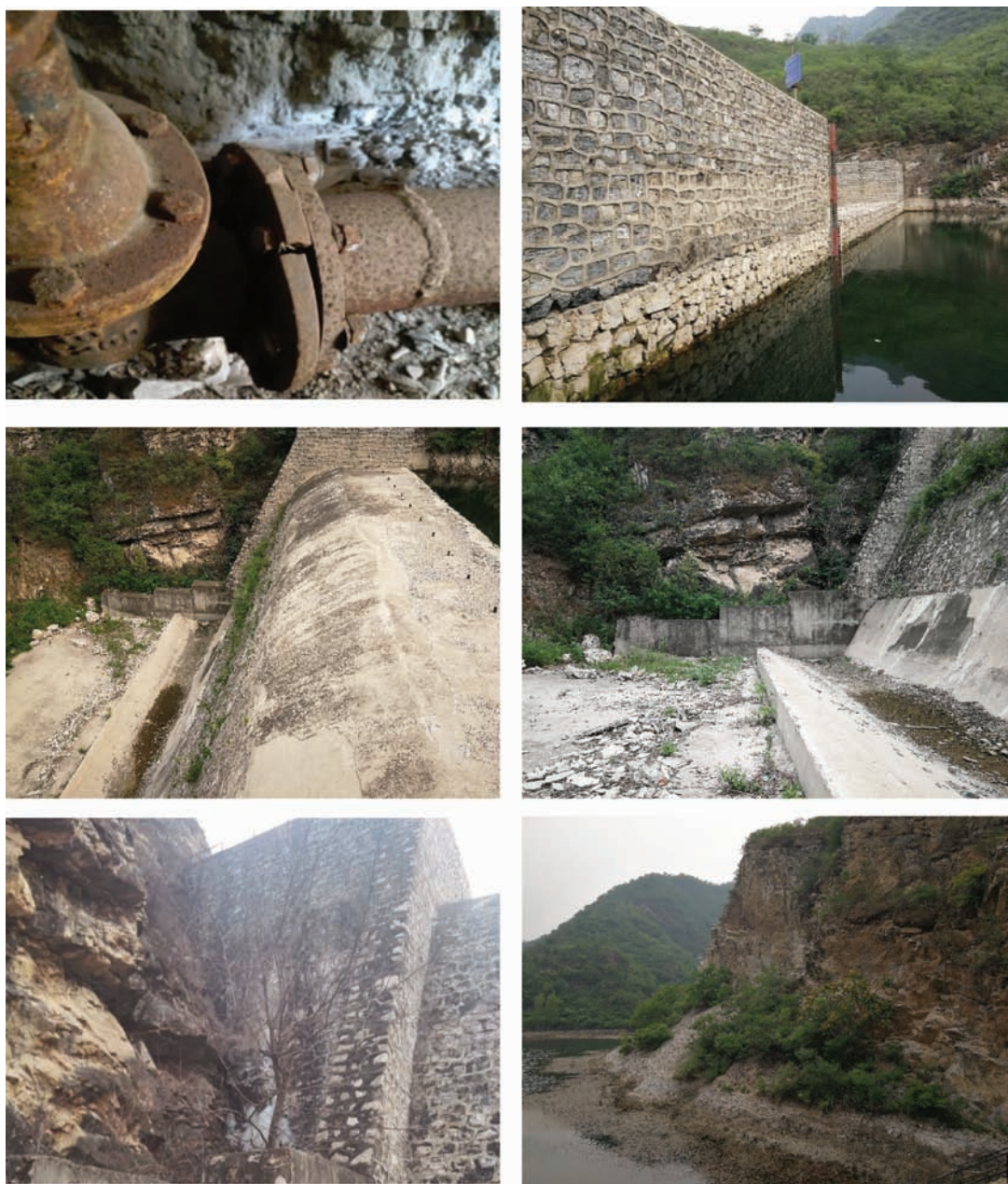
图1 砌石坝现场安全检查典型问题
