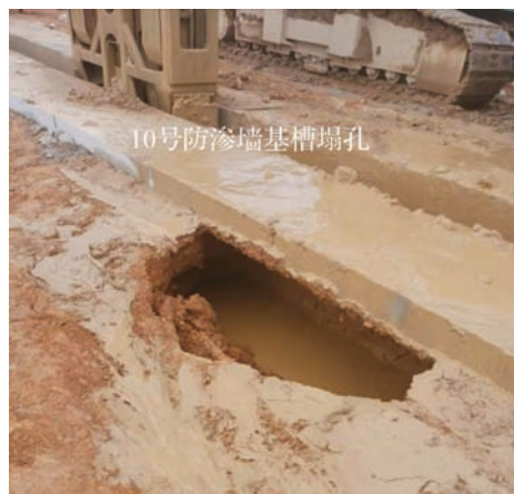
图 6 10 号槽段塌陷返工处理
