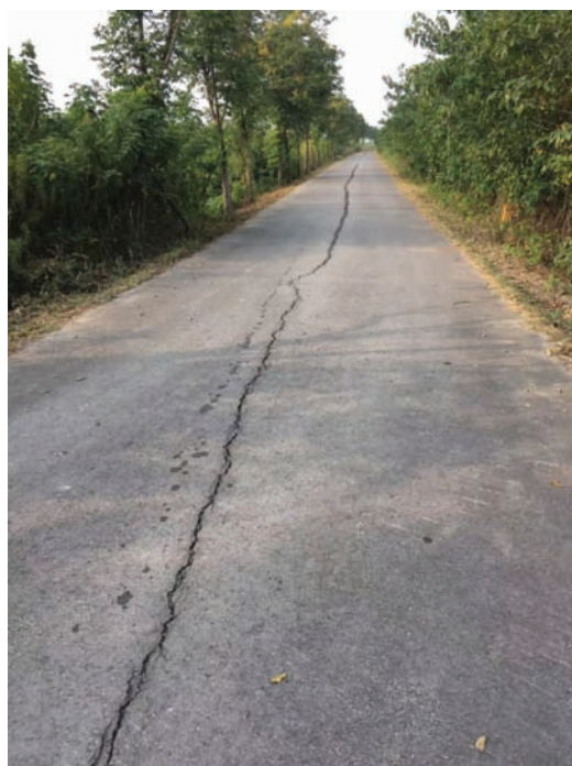
图2 堤防道路裂缝
