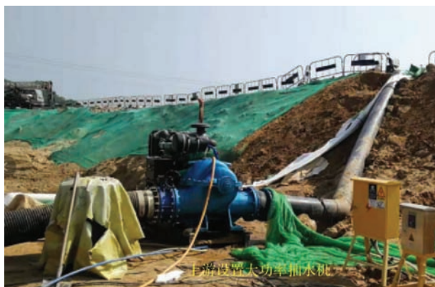
图 11 上游围堰旁大功率水泵降水
