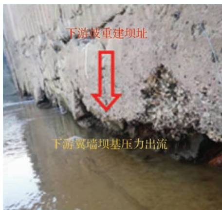
图 2 下游翼墙坝基压力出流
