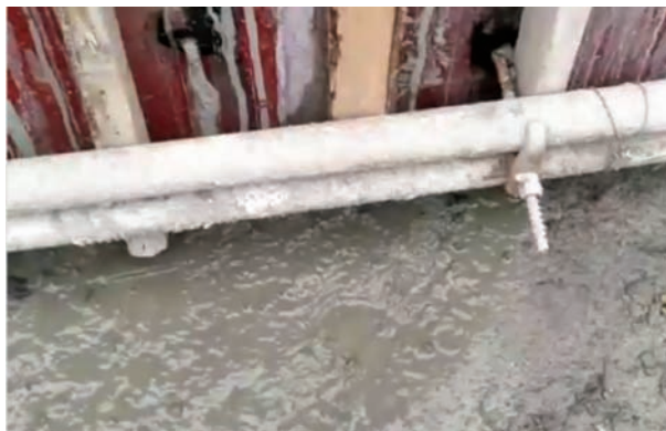
图 5 左岸基础固结灌浆(试验)漏浆现场照片
