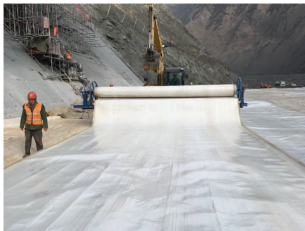
图4 土工膜快速收放机工作过程
