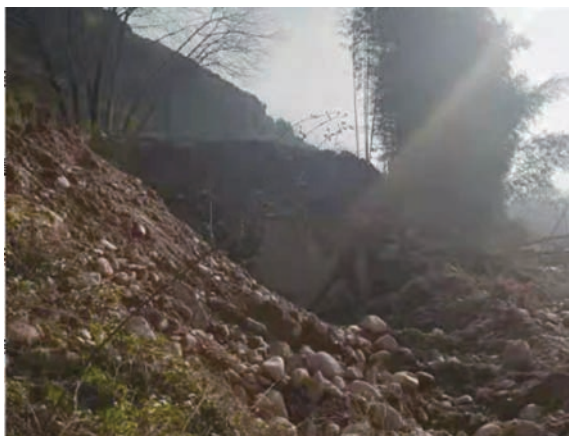
图3 鸡公石崕段岸坡局部坍塌
