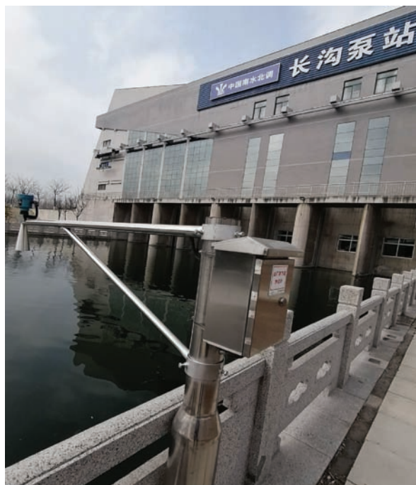
图6 雷达水位计实际安装效果
