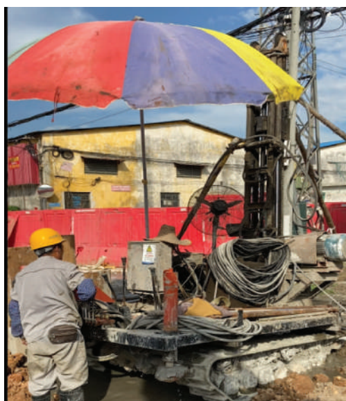
图10 旋喷成桩结束后移至下一孔位
