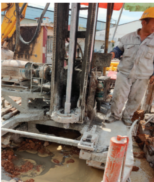
图8 旋喷膨润土泥浆成桩结束
