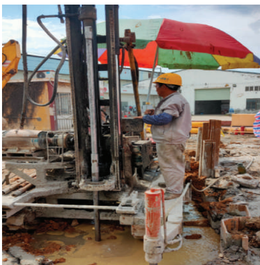
图7 旋喷膨润土泥浆
