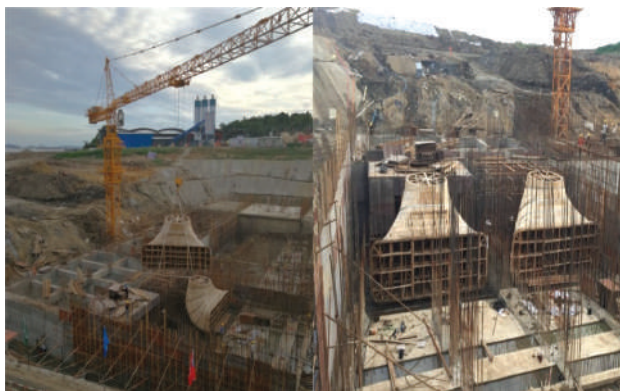
图3 异型流道木模塔吊整体安装
