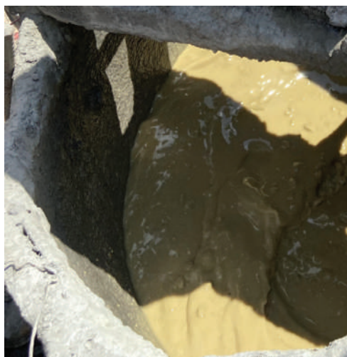
图6 按试验配合比配置膨润土泥浆用于初喷
