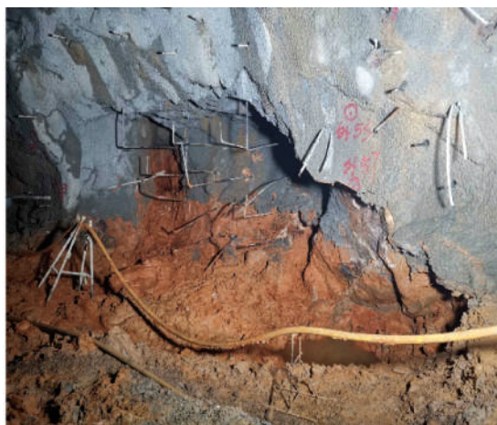
图1 地下厂房开挖揭露的溶洞照片
