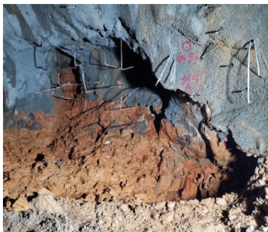
图1 地下厂房开挖揭露的溶洞照片
