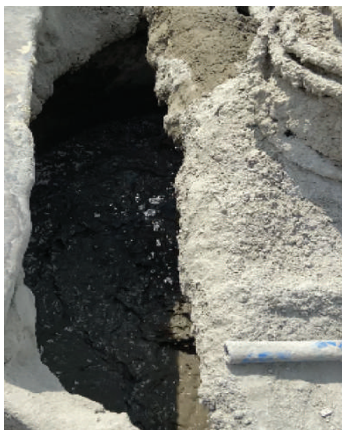
图9 按设计要求制备水泥浆用于复喷
