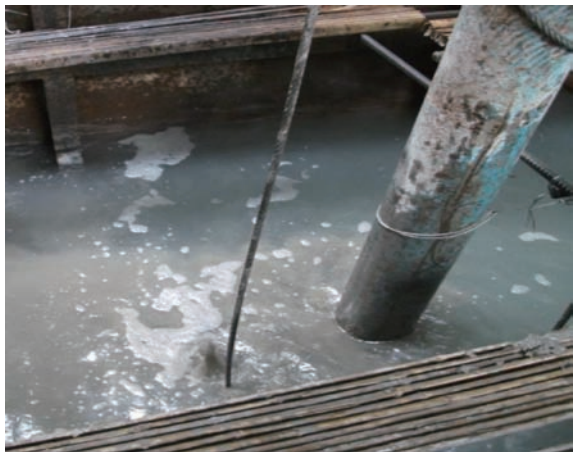
图13 水下混凝土浇筑施工场景
