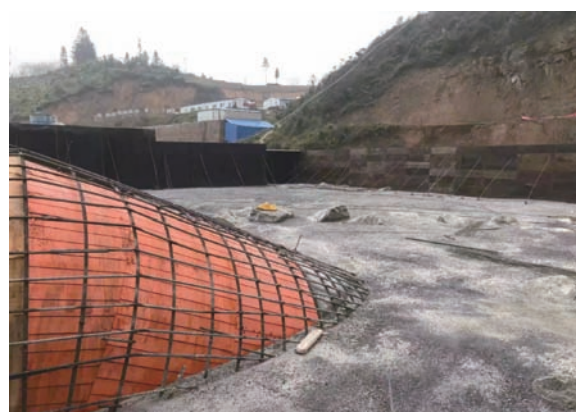
图13 顶拱浇筑成型混凝土
