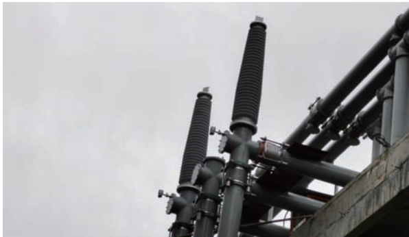
图 6 现场临时试验套管安装
