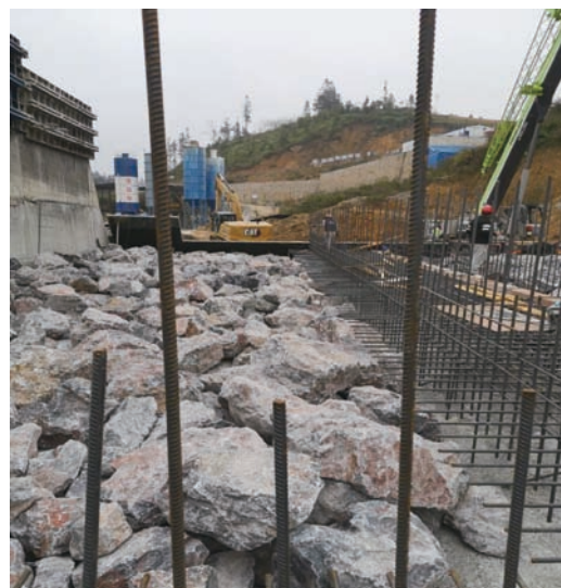
图 1 底板及部分侧边墙钢筋布置
