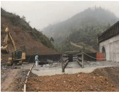
图4 侧边墙、顶拱钢筋绑扎及模板支立
