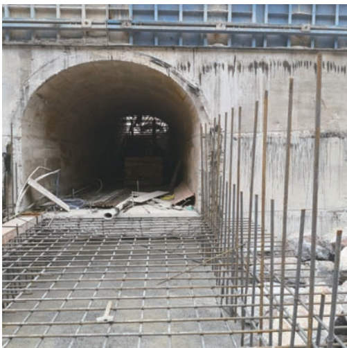
图5 堆石混凝土层高同步上升（廊道形成）
