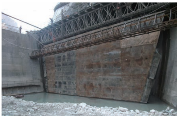
图10 模板箱体下水施工场景
