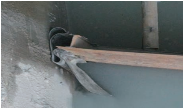
图5 水下混凝土模板专用防漏浆装置
