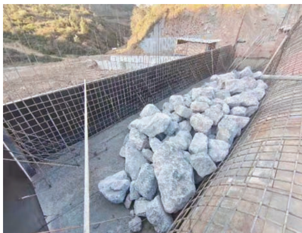
图9 侧边墙及顶拱处堆石 (一)
