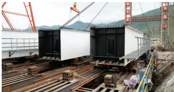
图5 钢导梁现场布置
