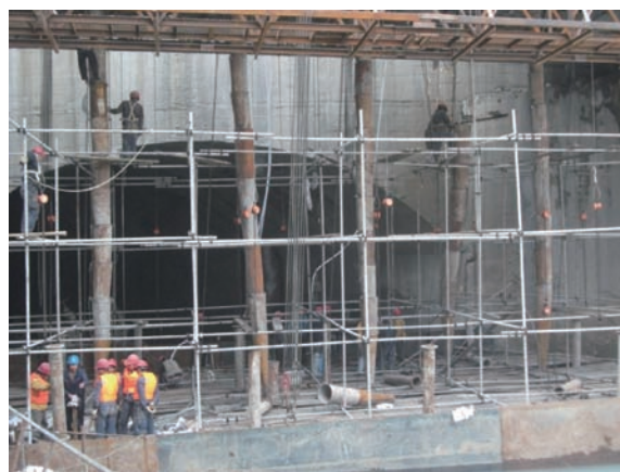
图11 操作排架搭设
