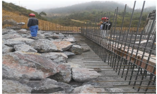
图7 底板钢筋布置和底板处堆石
