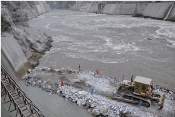
图3 防浪丁坝填筑施工
