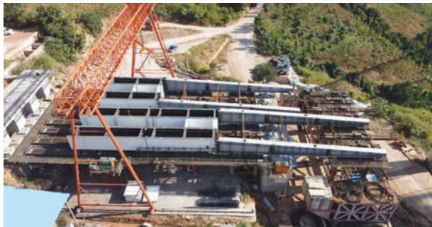
图2 顶推现场布置和过程控制情况
