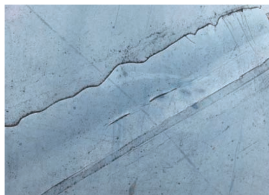
图5 坝袋搭接黏合处外层胶老化、损伤开裂
