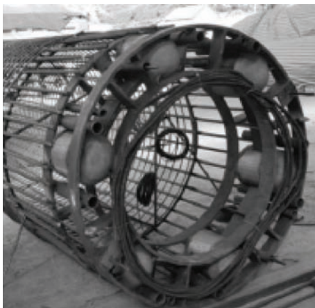
图1 荷载箱安装示意
