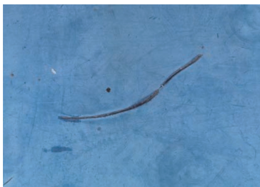
图4 坝袋外层胶损伤、开裂
