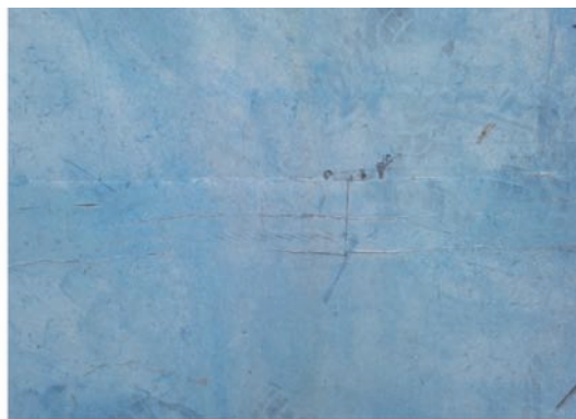
图3 坝袋表面老化龟裂、搭接处表层胶老化开裂
