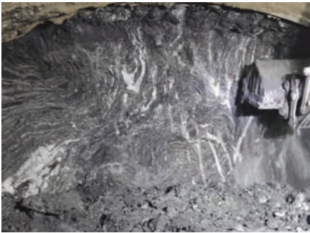
图3 DLII47+028.5 开挖揭示的围岩地质情况
