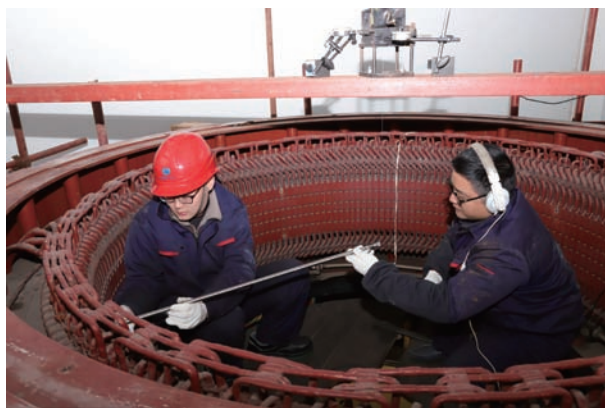
图1 电气回路辨声法——测量机组垂直同心
