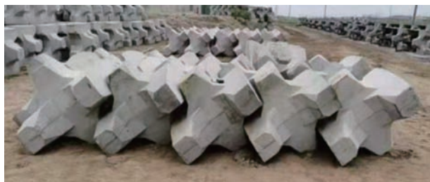
图7 扭王字块一边一足着地双向嵌固现场摆放图(侧面)
