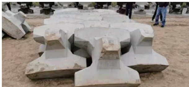
图6 扭王字块一边一足着地双向嵌固现场摆放图(正面)
