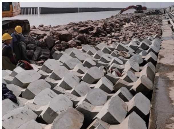
图9 扭王字块双向嵌固安装施工
